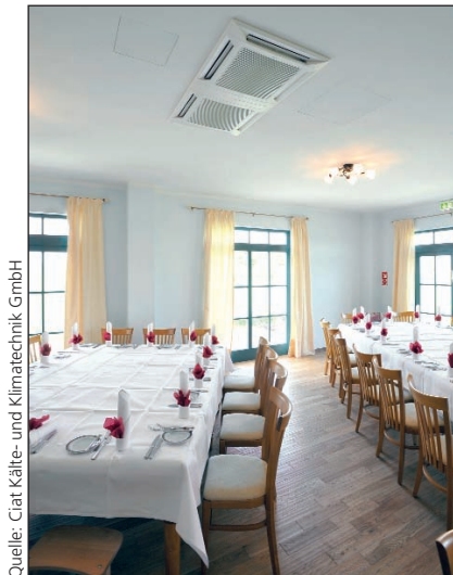
Bild 2: Zur Kühlung der Räumlichkeiten im Erdgeschoss werden die Deckenkassettengeräte »Melody WA 63« und »Melody WA 123 2 TFC« eingesetzt
