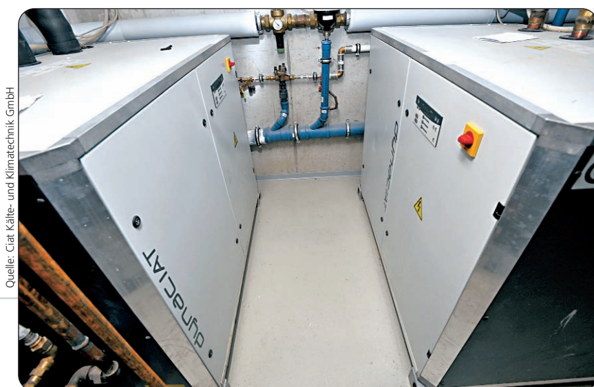
Bild 1: Unter beengten Verhältnissen wurden die zwei Wärmepumpen vom Typ Dynaciat 300V eingebaut
